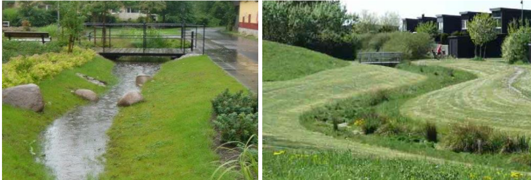
Figur 22. Augustenborg (t.v.) och Fjärilsparken, Malmö (t.h.) exempel på gräsklädda diken med flack släntlutning (Svackdiken). (VA-SYD, 2008)
