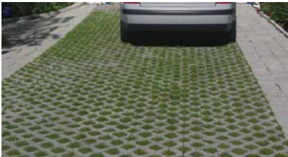
Figur 10. Genomsläpplig rasterbeläggning på parkeringsplats. (Uppsala vatten, 2014)
