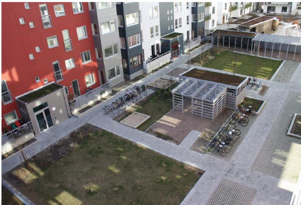
Figur 4. Innergård Västra Hamnen, Malmö. Gröna ytor samt vattengenomsläppliga ytskikt. (Kävlinge kommun, 2014)
