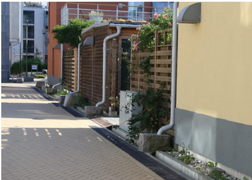
Figur 6. Bostadshus Västra Hamnen, Malmö. Stuprör med anslutning till öppen ytvattenränna. (Kävlinge kommun, 2014)
