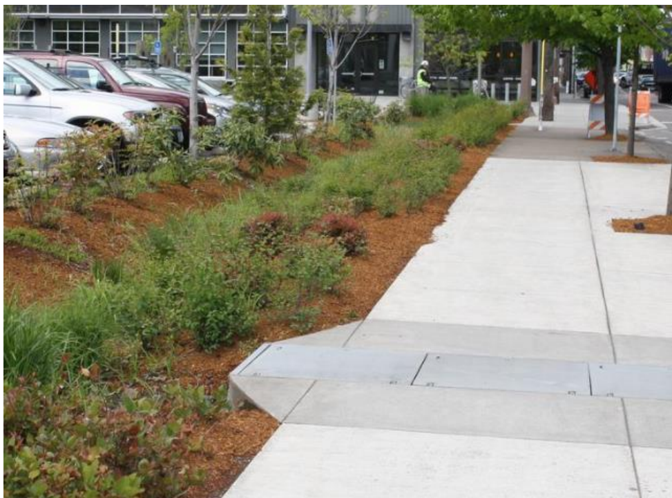
Figur 11. Parkeringsplats med avledning till regnträdgård. (Escholarship, u.d.)
